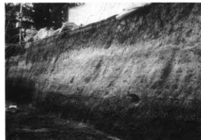
第16図 調査区北壁土層断面（南東から）
