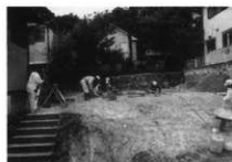
第7図 作業風景(東から)
