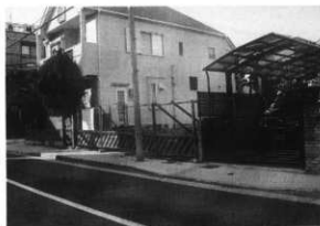
第1図 調査地近景（南東から）
