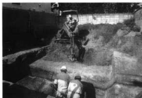
第4図 調査風景(南東から)
