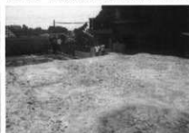
第15図 埋め戻し状況(北西から)
