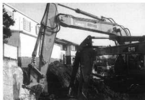
第12図 調査区機械掘削状況（南西から）
