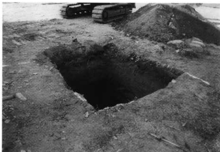
第1トレンチ（南西から）
