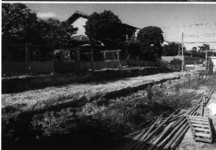
盛土等除去後の調査地 （南西から）
