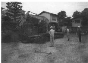
試掘トレンチ掘削風景
