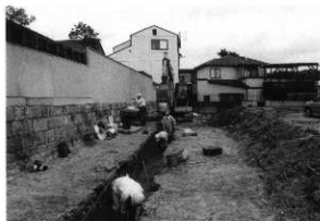
第4図 1トレンチ掘削風景
