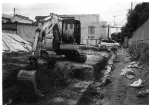
第7図 重機掘削風景
