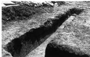
第6図 3トレンチ掘削状況
