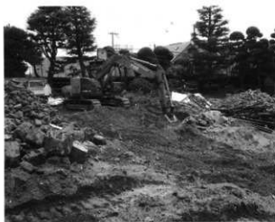
第8図 既存建物の解体状況
