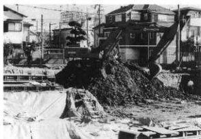
第10図 第15地点調査風景（重機掘削）
