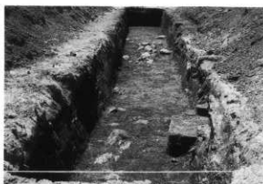
第29図 第36地点2 トレンチ全景（北から）
