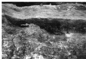
第38図 S K01・02掘削状況（南から）
