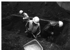
第15図 人力掘削風景
