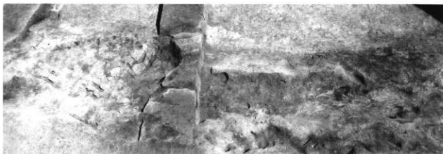
第33図 S D01完壁状況（西から）
