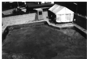
第22図 周濠検出状況（西から）
