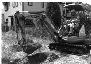
第14図 重機掘削風景
