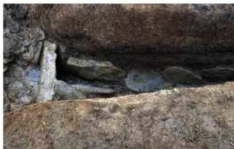
(4) 30号墳墳丘外埋葬施設排水溝(北より)
