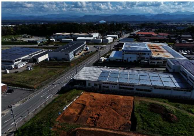
調査区前半及び調査地全景（西から）
