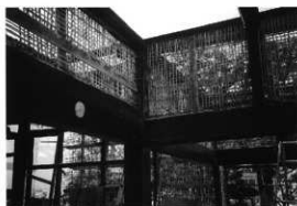
解体調査風景 (3)
