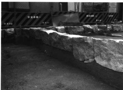
地覆石南列（南東から）
