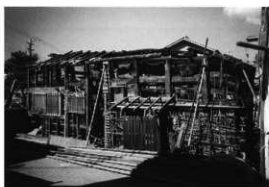
解体調査風景 (2)
