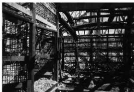
解体調査風景 (4)
