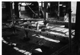
解体調査風景 (5)
