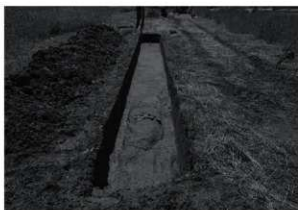
図19 Tr. 9調査区全景写真(北から)
