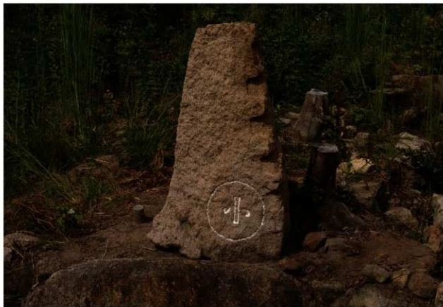
1号石材（南西から）
