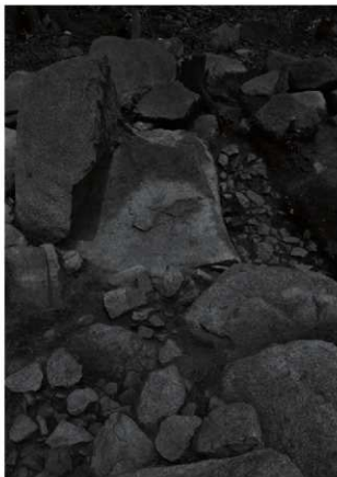
第65図 1区掘削状況（南西から）
