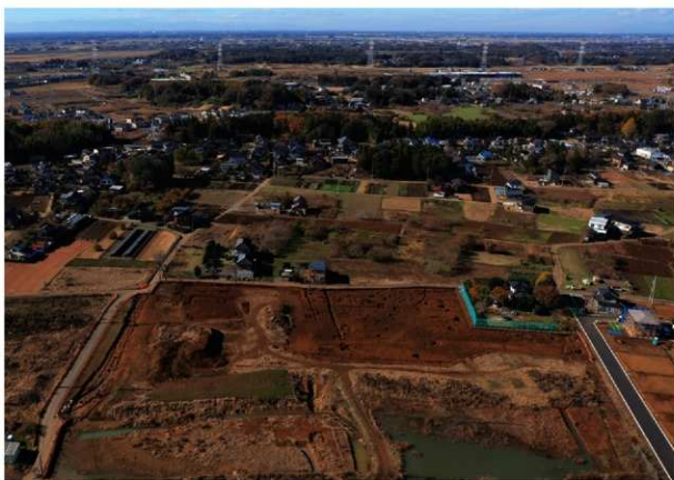
平成31年度調査C区西半部遠景（東から）
