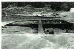
同 覆土堆積状態
