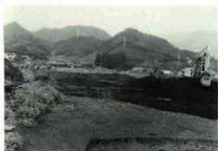
重機による表土掘削
