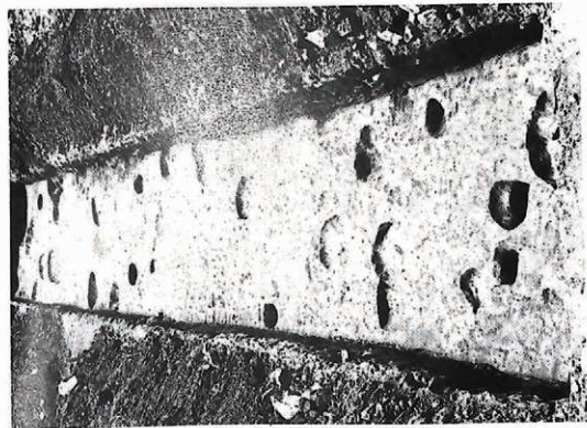
図版 1 第7次調査トレンチ全景 (西から)・(斜南東トレンチ (北から))
