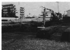
第2図 表土剥ぎ風景（南西から）
