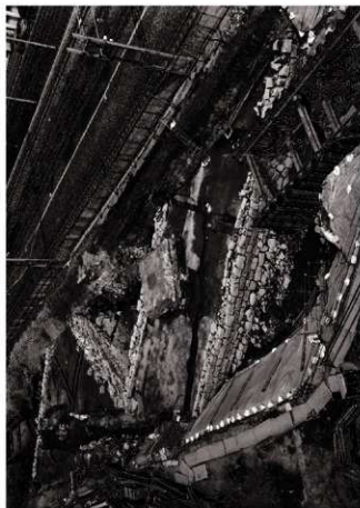
(3) 三ノ丸・土橋全景 (南西より)
