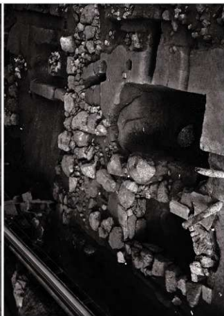
(4) 溜枳34450 (右は試掘坑) (南より)
