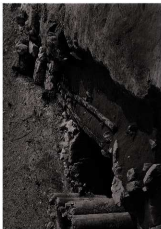
(1) 三ノ丸東石垣下胴木組 (北より)
