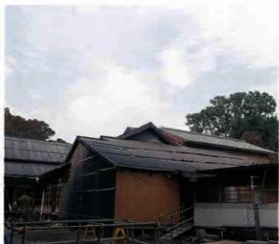
第35図 解体前の中蔵（南東から）
