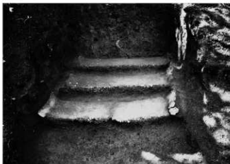
第5図 検出した南側の階段
