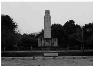
第40図 忠霊塔全景（西から）
