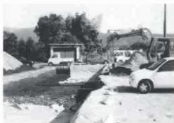
第6図 表土剥ぎ状況（北から）
