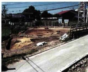
第11図 B区西侧全景（東から）
