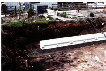
第8図 SX 1延長状態 (南西から)
