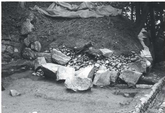
図版 3 搦手門台東石垣北面崩落状況（北より）
