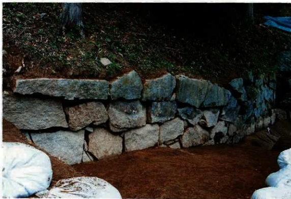
2 7a区石垣精査状況 (北西より)
