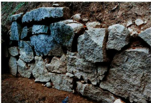
2 7b区石垣精査状況（南西より）
