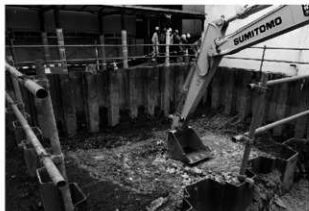
4 浄化槽上部解体とシートバイル設置完了 (工程 [2] [3])
