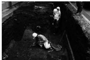
5 2区表土掘削状況（北から）
