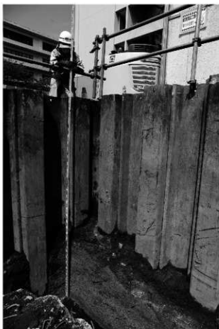
2 東壁北側 土層残存状況 (工程 (5))
