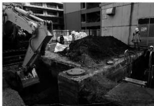
1 浄化槽周辺攪乱層の掘削 (工程 [1])
