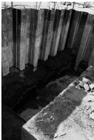
5 浄化槽周辺掘削完了。西壁 (工程 [4])
