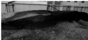
2 OT10 断面 (南東から)
