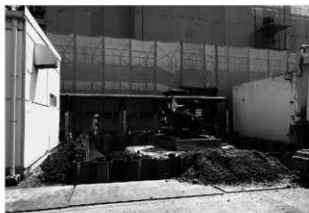
3 浄化槽上部解体とシートバイル設置 (工程 [2] [3])
