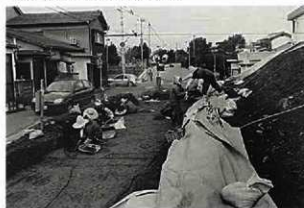
(8) 作業風景② (東から)
