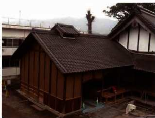
第10図 再組立中の釜屋(北東から)
