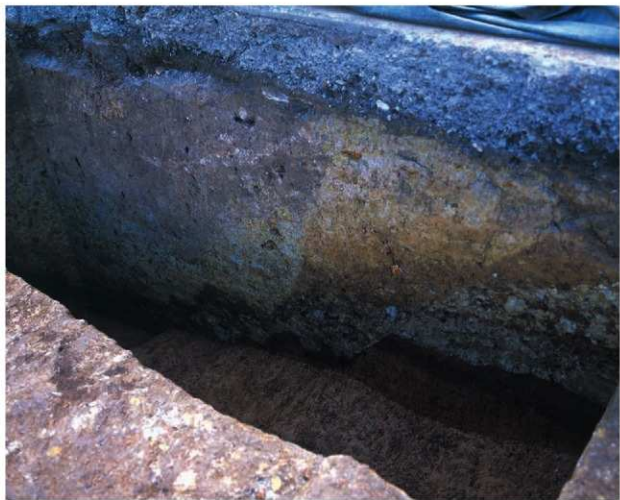
久留米城外郭を囲繞する土塁の断面。地滑りの痕跡が確認された。
