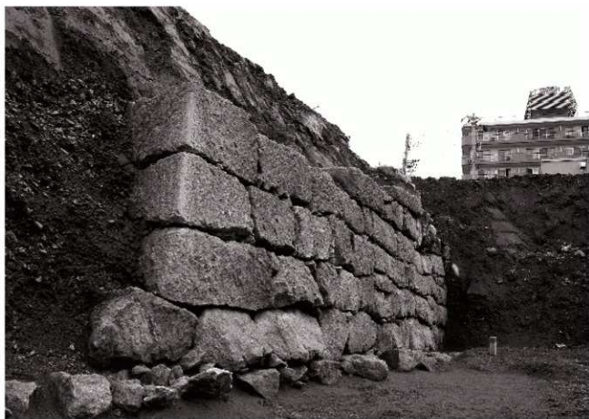
(2) 石垣角部(南東より)
