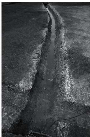
① A1 区 1号溝完掘（南から）
