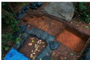
擁壁き検出状況〔南より〕
