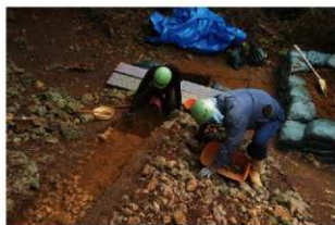
掘削作業状況
