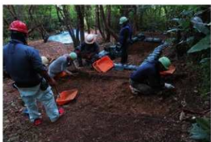
掘削作業状況
