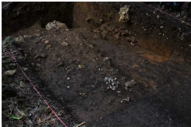
土留め横出状況
