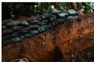
地山確認状況〔西壁〕
