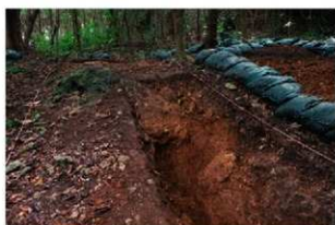
掘削後状況〔北西より〕
