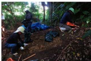
掘削作業状況
