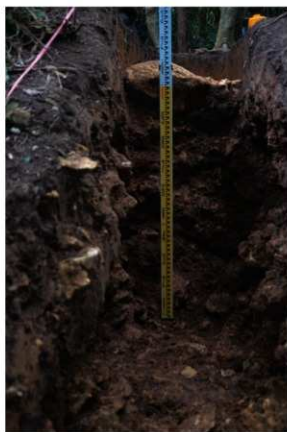
土留め縦断面状況
