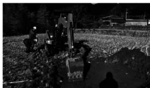
写真3-2 重機による掘削状況
