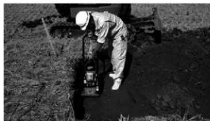
写真3-4 埋め戻し（ランマによる転圧）状況
