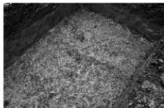
写真3-8 49tr 噴砂検出状況
