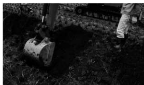
写真3-2 重機による掘削状況
