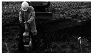
写真3-4 埋め戻し（ランマによる転圧）状況
