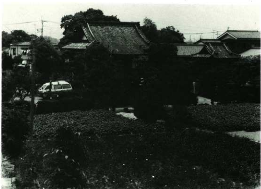
常福禅寺近景
