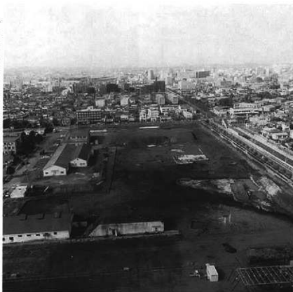
1. 駿河道跡全景（東南上空から）
