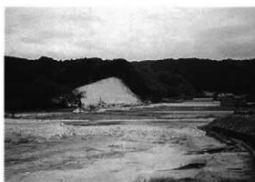
調査終了後、工事中の遺跡（西から）
