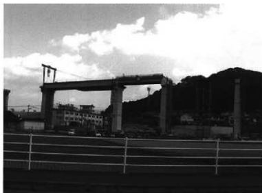
工事風景(那珂川町大字松木地内)
