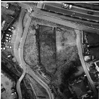
2. 本線調査区 (上空から)
