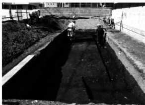
図3 作業風景（南から）
