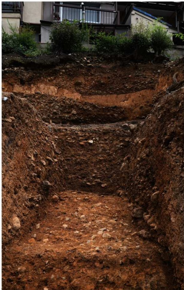
3. 土塁盛土断面（南西から）
