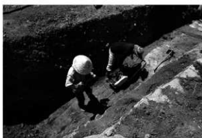
図6 埋め戻し状況（北東から）
