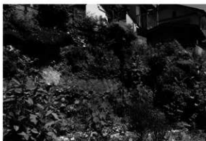
図2 盛土露出状況（北西から）
