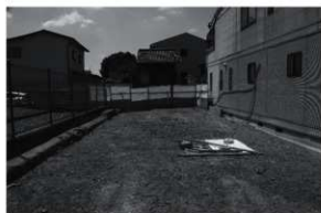
図5 埋め戻し完了風景（北から）
