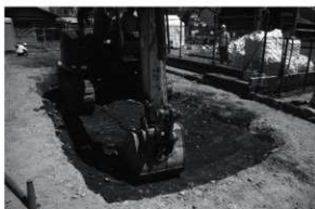
図4 埋め戻し作業（南西から）
