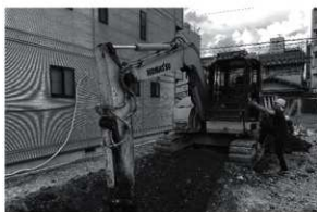
図2 重機掘削作業（南東から）
