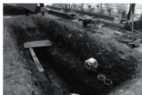
図3 人力掘削作業（南西から）
