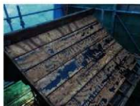
図8 田中社屋根解体
