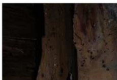
図11 柳社北東柱の台鉋の痕跡
