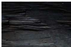
図5 田中社床板の台鉋と槍鉋様の痕跡
