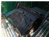
図17 稲荷社屋根解体
