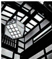
写真19 皆美別館吹抜
