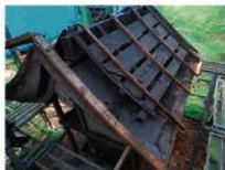
図14 若宮社屋根解体
