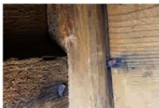
図18 稲荷社北西柱の台鉋の痕跡
