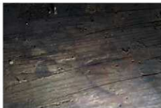
図19 稲荷社床板の台鉋の痕跡
