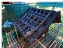
図10 柳社屋根解体
