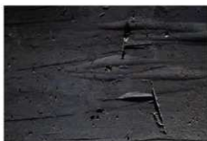
図12 柳社床板の台鉋と檜鉋様の痕跡
