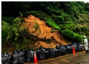
調査地全景（斜面下から）
