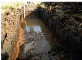
11号トレンチ土層堆積状況（西→）
