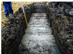
24号トレンチ土層堆積状況（西→）
