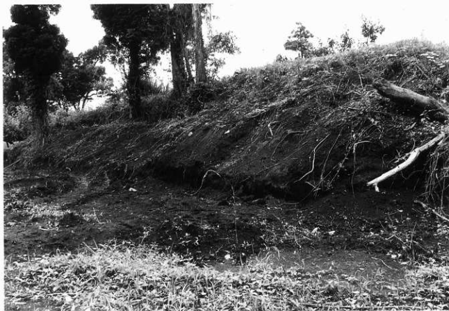
釘崎1号古墳 損壊発見時の状況（南より）
