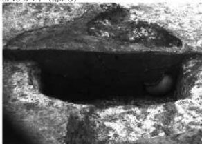
SI-11 張り出しピット（東から）
