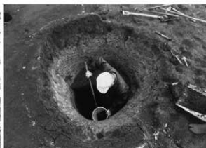
SK-1188 作業風景（北から）
