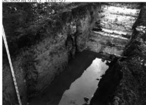
SE-1263・1264・1265 断ち割り完掘 (南から)
