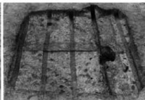
SI-03 掘り方検出状況（西より）
