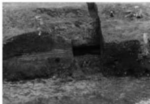
切岸部浸食状況（西より）
