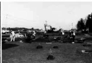
B区作業風景（西より）
