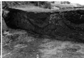
切岸部南側断面状況（北西より）
