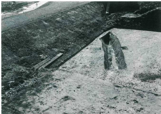
(2) 堤防下全景（北東方より）
