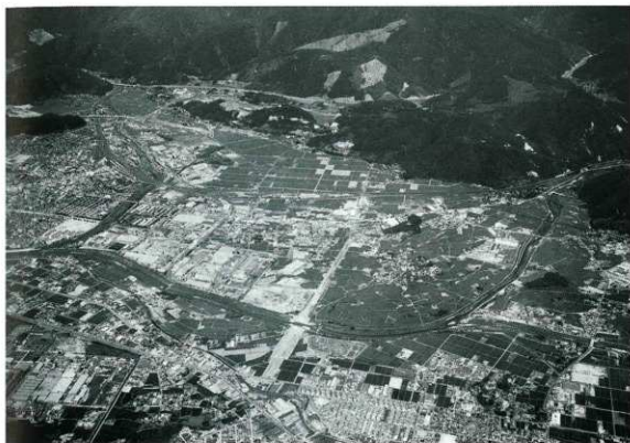
(2) 東部地区（西方上空より）
