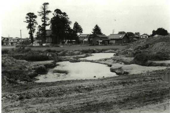
(1) 東方より見た全景
