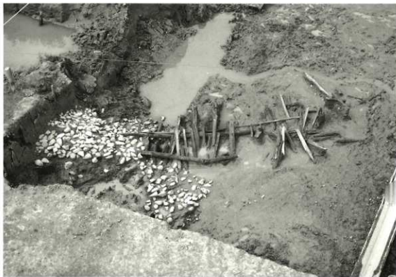
(1) 南方より見た石積・木組両遺構の出土状態
