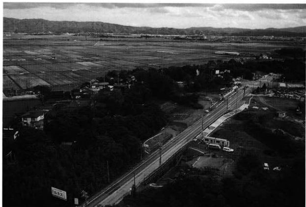
1. 調査区俯瞰（北西より）
