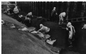
土塁盛土の調査
