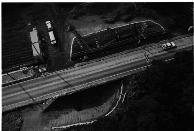
2. 調査区全域空中写真
