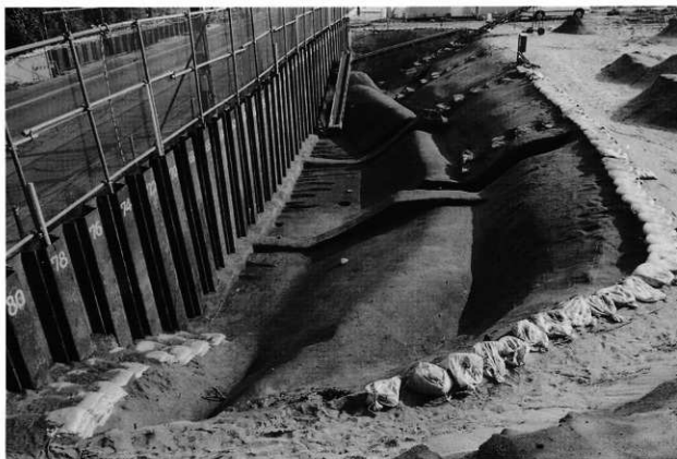
2. 土壁全景（北より）
