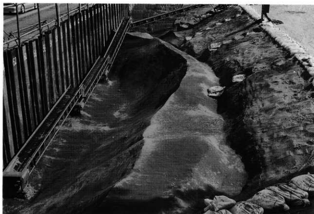
1. 表土除去後の土壁（南より）
