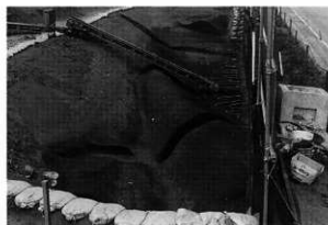
2. 改修前の土壁（南より）
