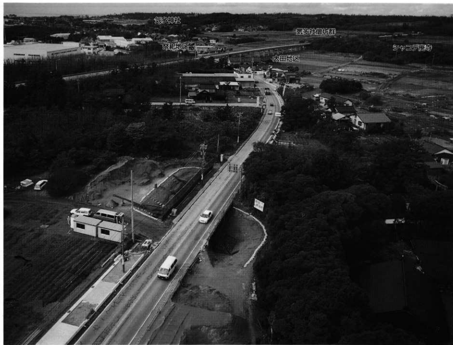
調査区俯瞰（南東より）
