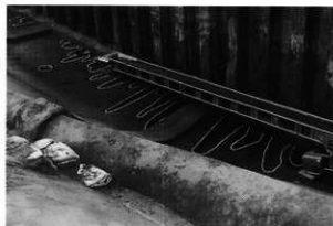
5. 畝溝とPit完掘（南西より）
