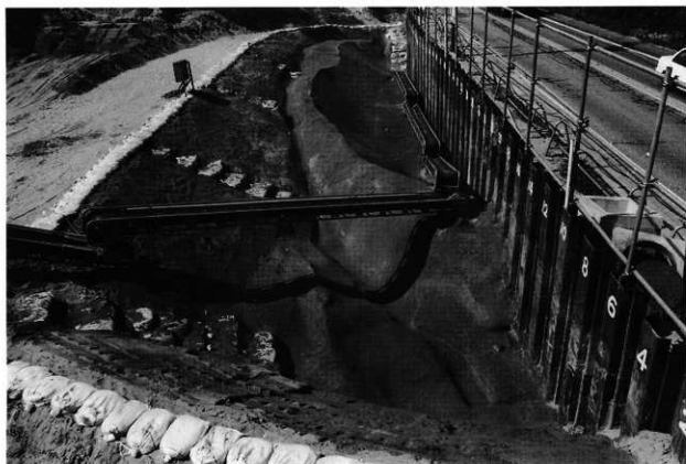
2. 表土除去後の土壁（北より）
