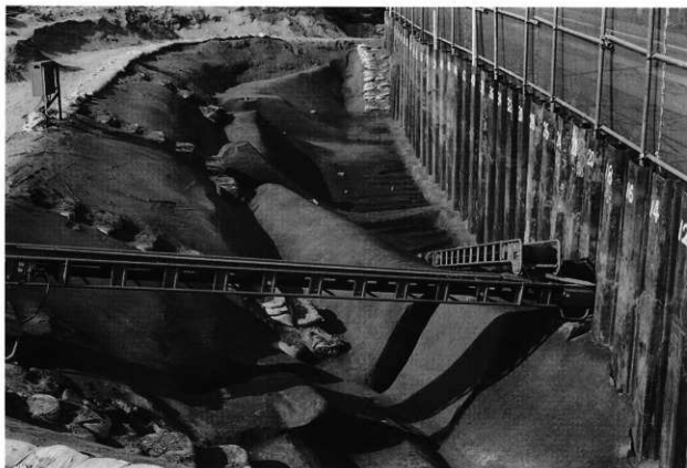
1. 土壁全景（南より）
