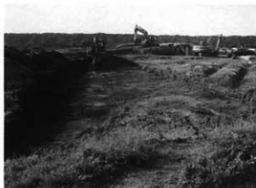
1. 表土除去作業 (南東より)
