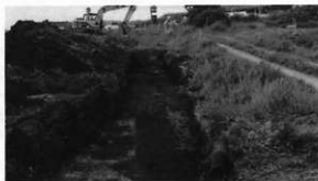
第Ⅲ地区表土除去風景
