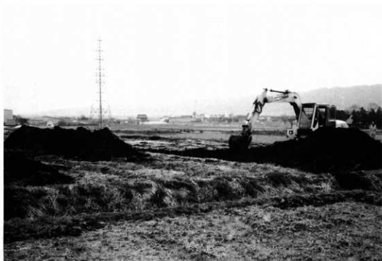
(2)バックホーによる荒掘り(東から)
