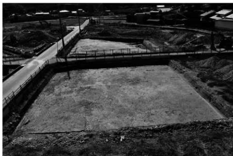
2. 調査区3-1・2 (北から)
