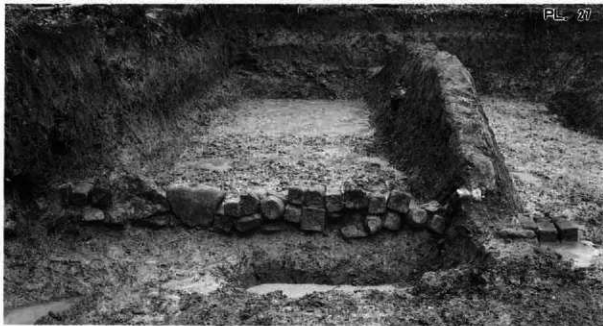
1. A段石造遺物 転用石積み (南から)
