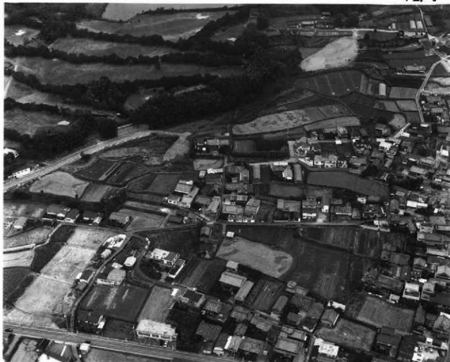
1. 第I区と北側の状況 (南東上空から)
