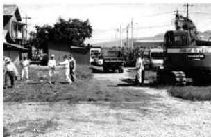
写17 調査地作業前全景
