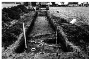
写真35 トレンチ全景 北から
