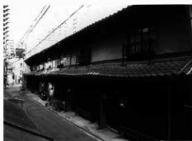
龍造寺町に残る明治43年に建てられた長屋で、間口が2.25間と一般的な規模である。
